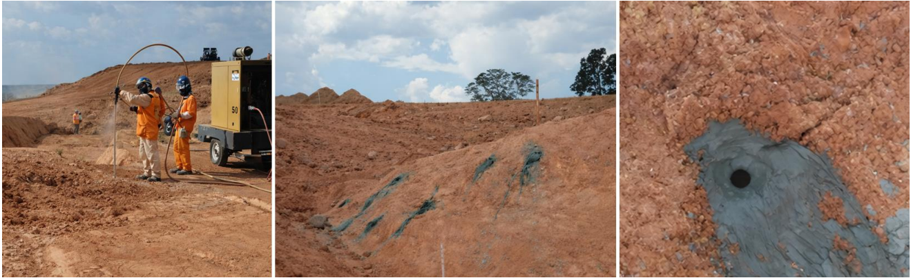
Figura 2. Tratamentos realizados em escavações com presença de canaliculos
